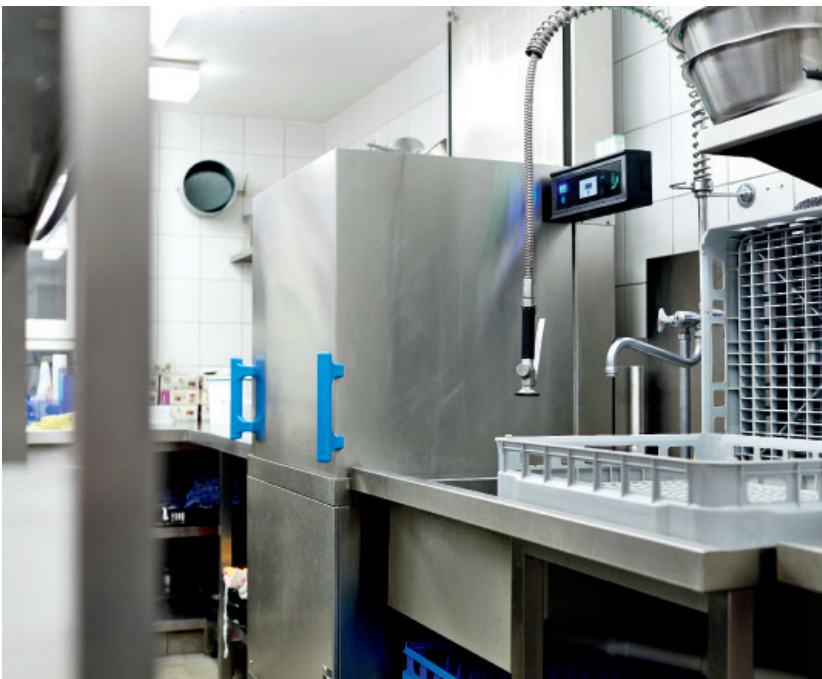
Ergonomie durch optimierte Spültechnik: Die Haubendurchschubmaschine M-iClean H von Meiko ist u.a. für kraftschonendes Be- und Entladen konzipiert.
